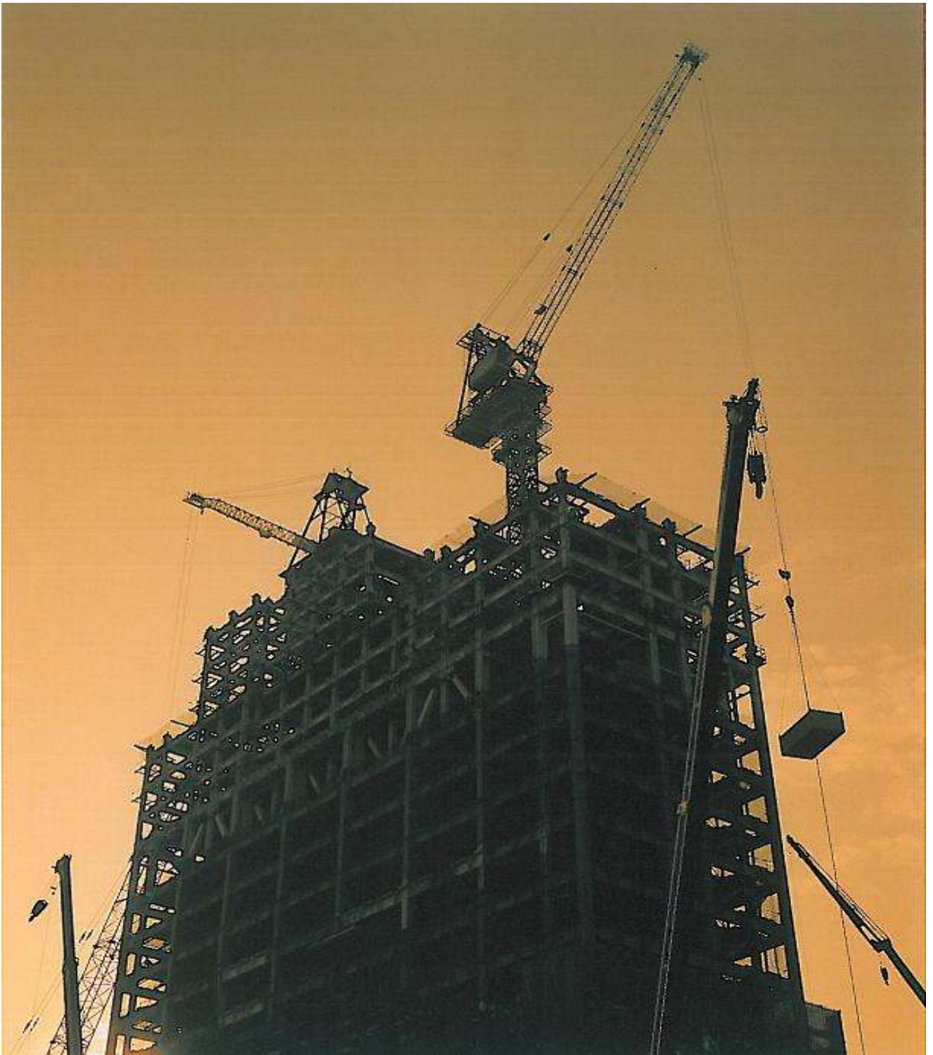
高層建築と、その建設を担うクレーン。
